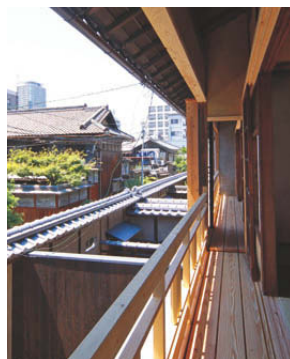
改修した長屋の2階から母屋を見る
